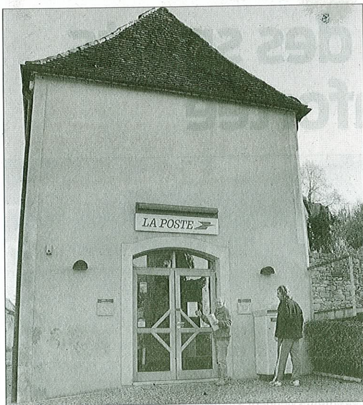
Le chantier doit durer jusqu'au 24 novembre. PHOTO A. MARTIN-AUBERDON
